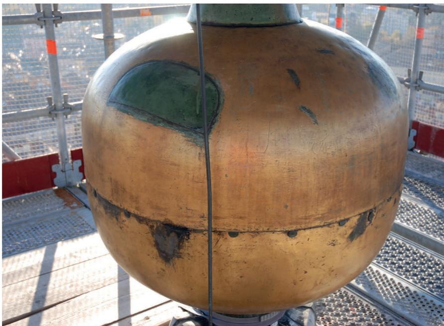
con la messa in opera di 2 cerchiature metalliche esterne e cuciture delle lesioni verticali con fibre di carbonio.
